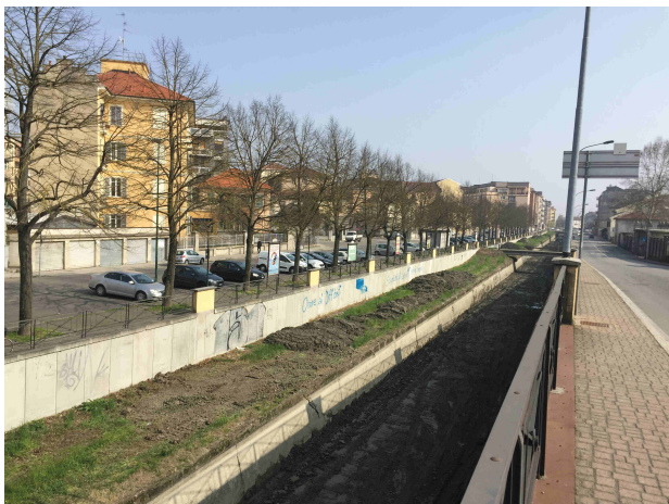
Foto marzo 2017 al momento dell'interruzione delle attività di dragaggio – rivestimento pareti evidente lato fronte stadio Natal Palli.
